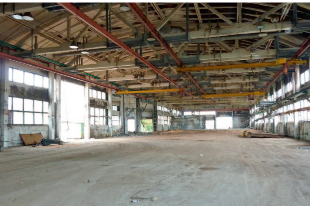
Рис. 5. Цех во время демонтажа и реконструкции
