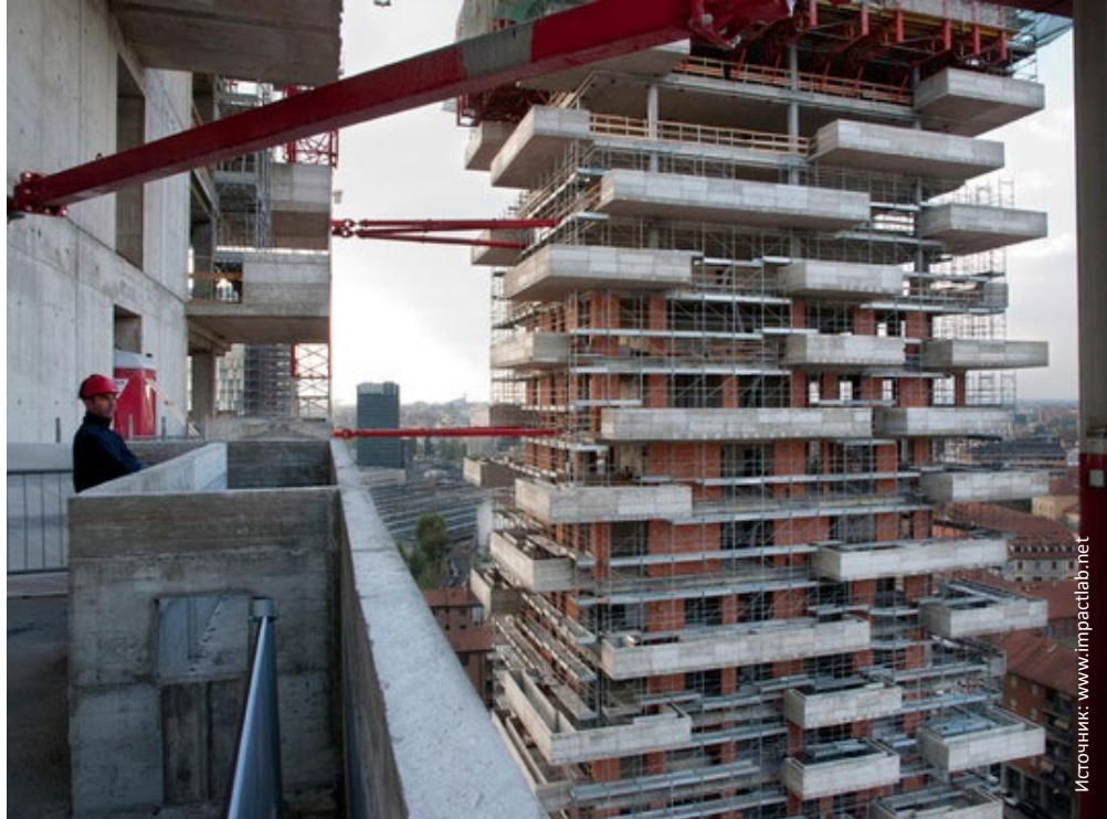
Несущие конструкции и плиты перекрытий здания изготовлены из железобетона непосредственно на объекте
