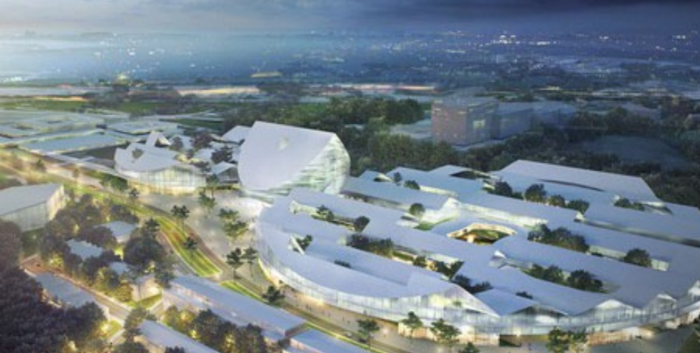
Инновационный центр «Сколково» после завершения строительных работ
